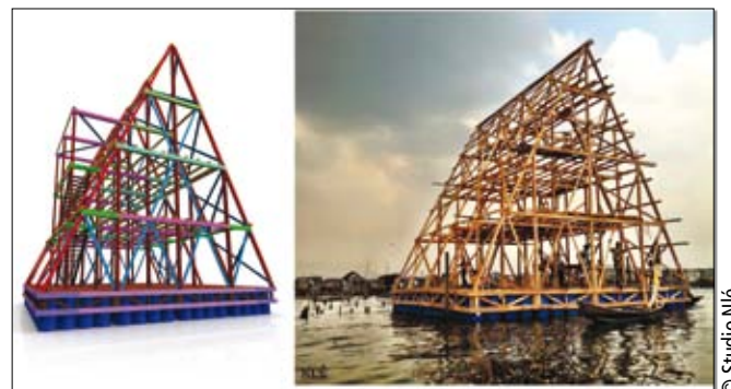
Construction d'un prototype d'école flottante à Lagos, par l'architecte et urbaniste Kunlé Adeyemi.
