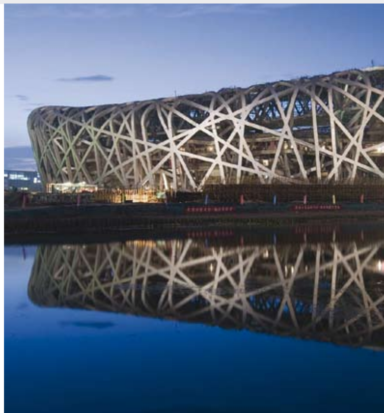
Le nid : une construction unique et un chantier terminé 4 mois avant la date !
