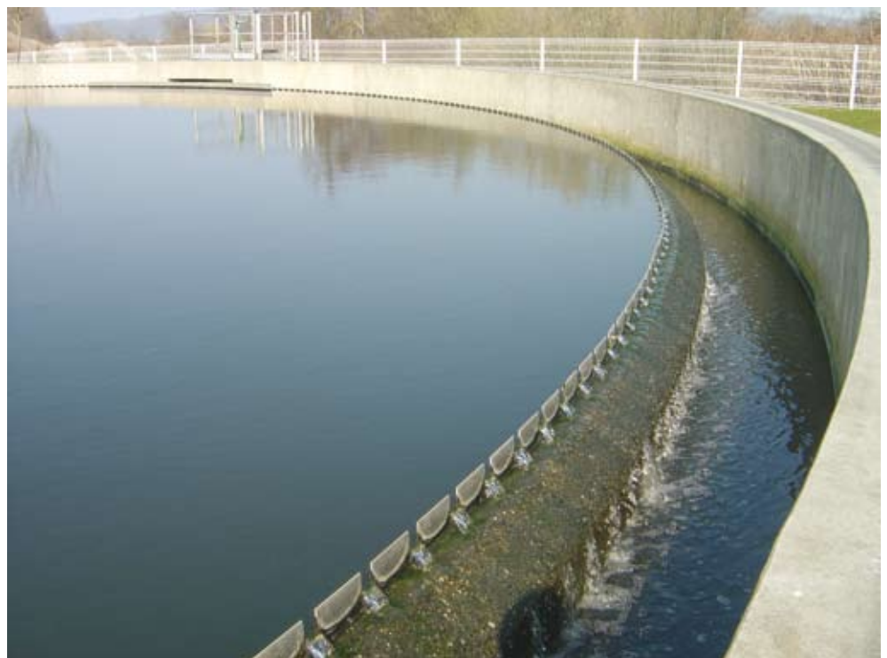
Le traitement de l'eau, une activité majeure de Veolia Environnement sur des projets de grande ampleur, exemple ce clarificateur de plusieurs dizaines de mètres de diamètre.
